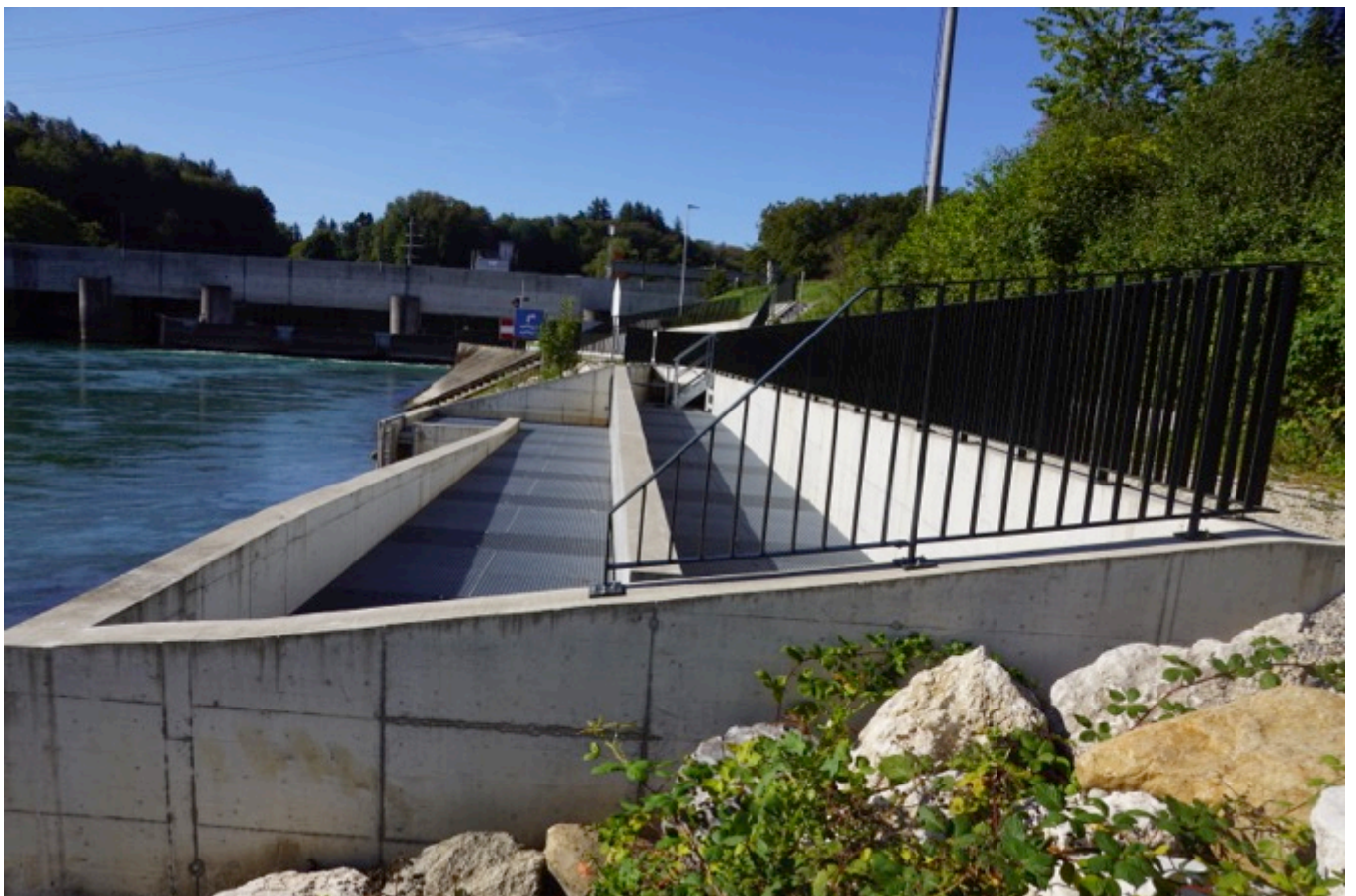
Das Einstiegsbauwerk für die schwimmschwächeren Arten,
